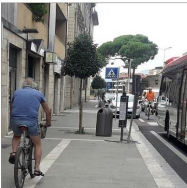
Nuovo percorso pedonale protetto o corsia pedonale a raso adiacente a sede carrabile, di h massima 2,5cm dal piano carrabile, in asfalto o conglomerato cementizio, variabile a seconda del contesto, protetta tramite ciglio di 10cm segnalato per materiale e colore.
