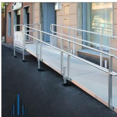
Nuova rampa di medie e piccole dimensioni, di pendenza massima 5%, larghezza minima 1,20m (non inferiore a 90cm) per consentire il superamento per il superamento di un dislivello di 50 cm (lunghezza rampa max 10 m); realizzata in alluminio o similare, modulare, di portata idonea, dotata di superficie antiscivolo forata, per consentire la dispersione spontanea di pioggia e neve senza pericolo.
