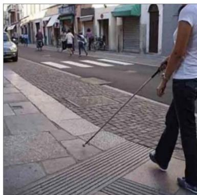
Nuovo percorso pedonale protetto o corsia pedonale a raso adiacente a sede carrabile, complanare alla sede carrabile o di h massima 2,5cm dal piano carrabile, in asfalto o conglomerato cementizio, variabile a seconda del contesto, protetta tramite ciglio di 10cm segnalato per materiale e colore. Valutare a seconda del caso se completare con cordolo battiruota, con corrimano o con elementi parapetonali.
