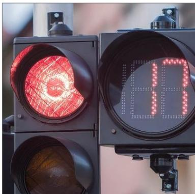
Adeguamento dei semafori esistenti tramite dotazione all’impianto di dispositivi smart: segnalazione acustica per non vedenti lungo la direzione dell’attraversamento, per permettere di “sentire” il messaggio dell’impianto ed essere dallo stesso guidati; scatoletta per la prenotazione dell’attraversamento pedonale con pulsante provvisto di dispositivo vibratile installata a 100 cm di altezza da terra; eventuale display contasecondi che indica i tempi di attesa del semaforo.
