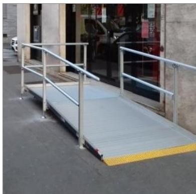
Per dislivelli superiori a 50 cm, dotazione di corrimano su un lato della rampa, di diametro 4 cm, fissato con appositi sostegni a terra a 90 cm di altezza su tutto lo sviluppo della rampa stessa e, possibilmente, con prolungamento in piano per 30cm di lunghezza. Per dislivelli superiori a 20 cm e corrimano non pieno, prevedere cordolo battiruota di almeno 10 cm di altezza.
