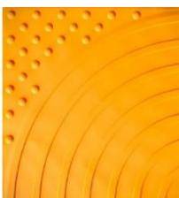
Il **segnale di svolta obbligatoria a 90°** è utilizzato per raccordare efficacemente ad angolo retto due tratti di percorso rettilineo, costituito da una combinazione dei canaletti e delle cupolette. È un quadrato di 60 cm di lato, recante canali curvilinei o obliqui, perfettamente in asse con quelli del Codice di direzione rettilinea, che uniscono i due tratti di
